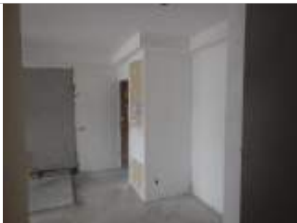
Vista da unidade
