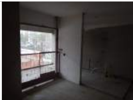
Vista da unidade
