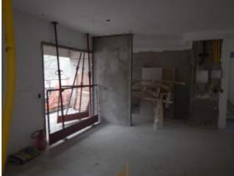
Visão Geral da Unidade
