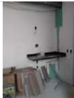
Vista da unidade
