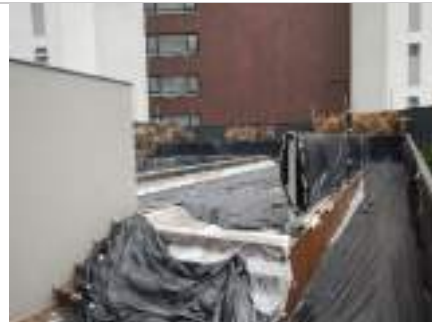
Piscina (em construção)
