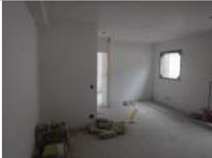
Vista da unidade
