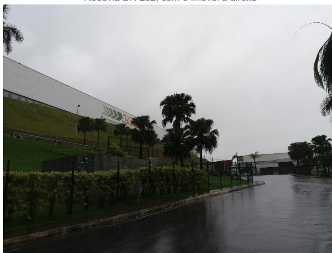
Rodovia BR-262, com o imóvel à esquerda
