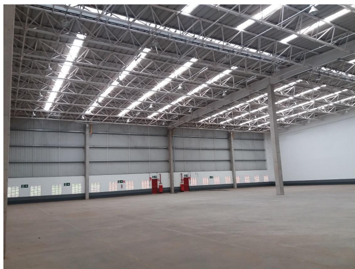
Vista interna do imóvel
