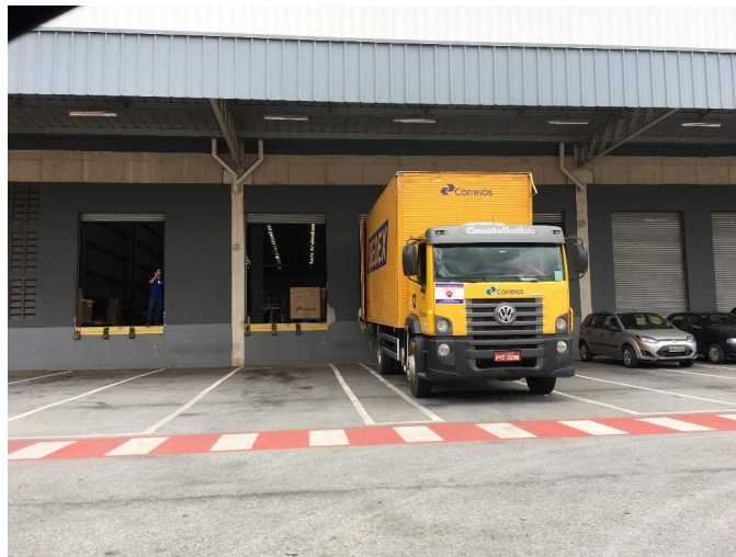
Área de galpão e marquise
