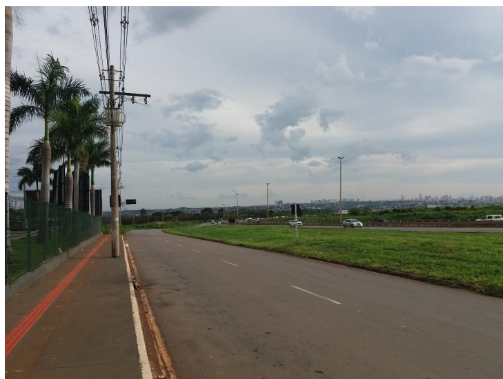
Rodovia BR-153, com o imóvel à esquerda
