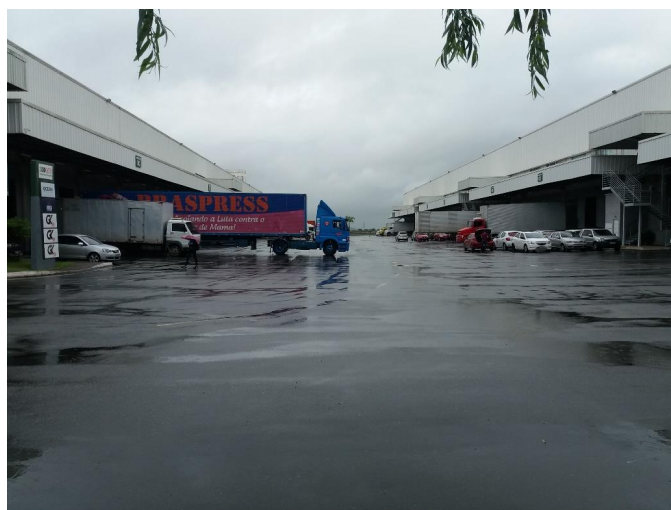
Área de manobra e docas do imóvel
