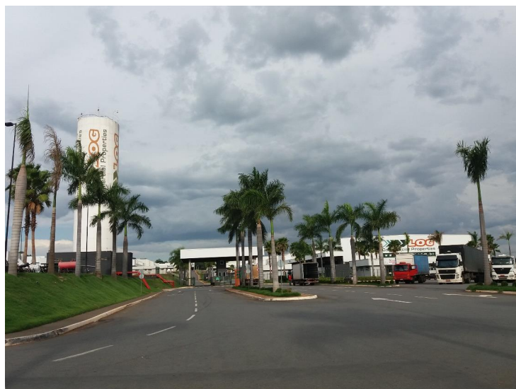
Frente do terreno para Rodovia BR-153
